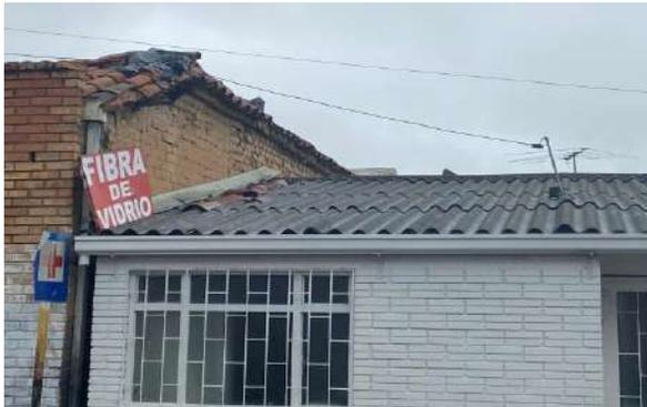
Estado inicial de la cubierta en asbesto cemento en la UBA Libertador
