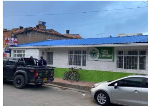
Cambio de cubierta, instalación final de la teja termoacústica en el faldón de la fachada principal e instalación de aguas lluvias.
